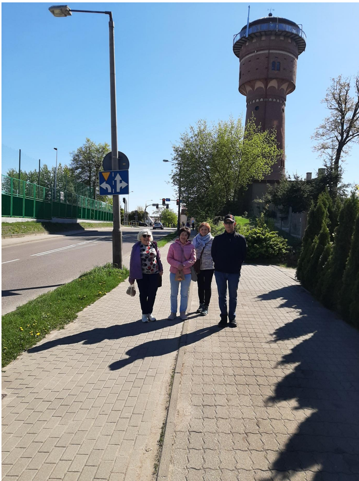
Zdjęcie nr 2 – Wieża Ciśnień w Giżycku.
